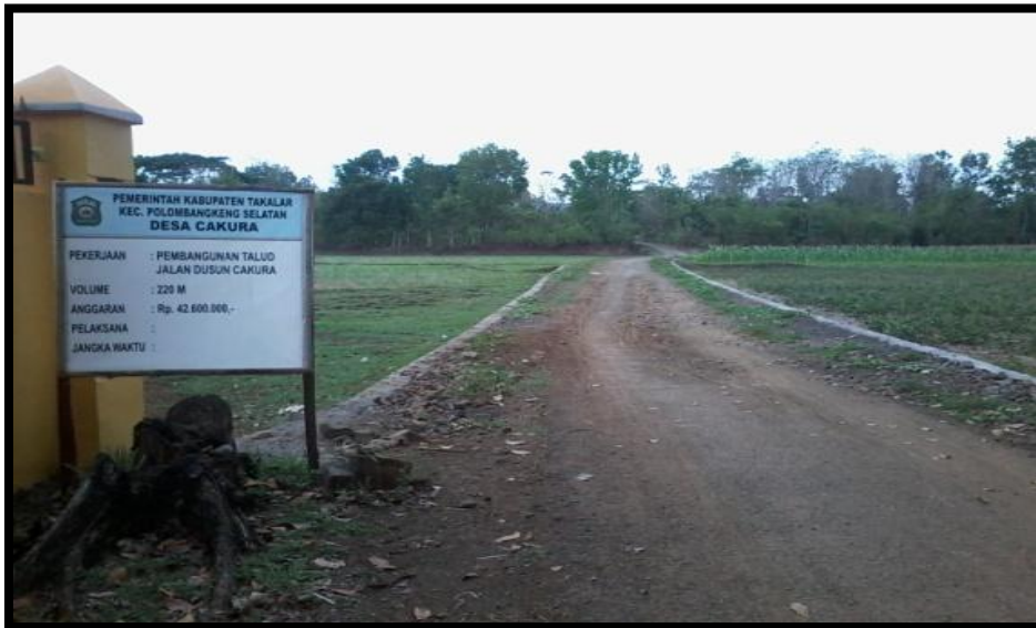
Pembangunan Fisik Dana Desa (Dok: 02 Oktober 2017)
