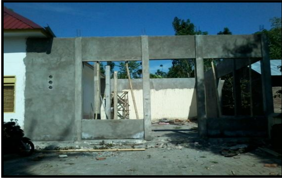
Pembangunan fisik Dana Desa (Dok: 27 September 2017)
