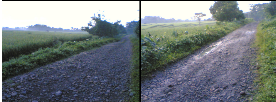
Gambar 4.2 Kondisi jalan pengerasan
