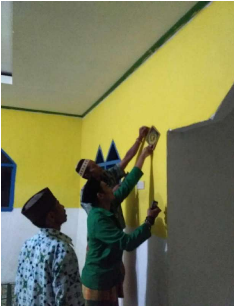
Pemasangan Kaligrafi di Mesjid Dusun Bulo-bulo
