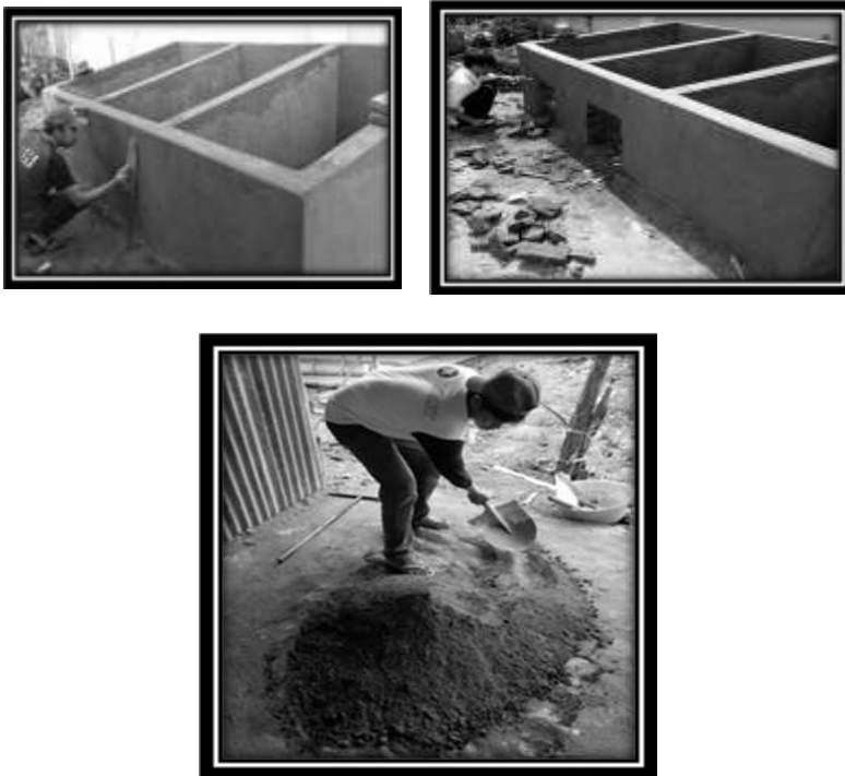
Gambar Tabel 4.14 Pembuatan bak tempat sampah di Puskesmas Cangadi
