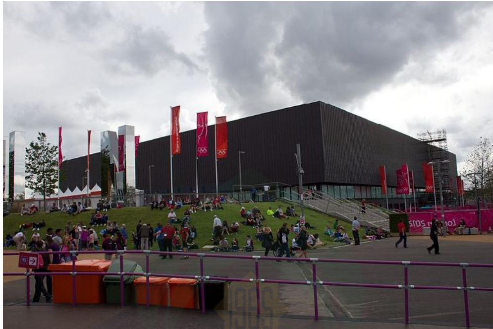
Gambar II. 29 Bangunan Copper Box (Sumber: http://en.wikipedia.org/wiki/File:Copper_Box,_4_August_2012.jpg , diakses tanggal 6 Mei 2015)
