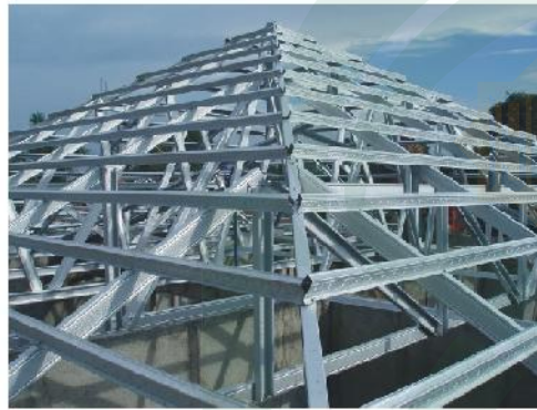
Upper struktur bangunan menggunakan struktur rangka atap baja ringan
