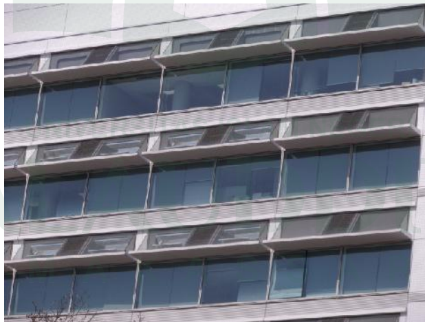
Gambar II. 33 Fasad pada bangunan Tsukuba Space Center Development and Promotion Building (Sumber: http://www.fck-sw.co.jp/FutabaTu-sin/2015.04.01.html , diakses tanggal 26 Mei 2015)
