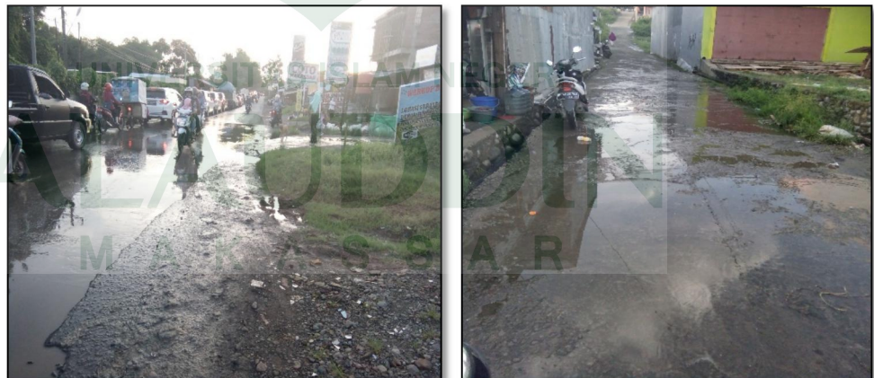
Gambar 4. Kondisi Genangan Air Limbah di Sekitar Pondokan
