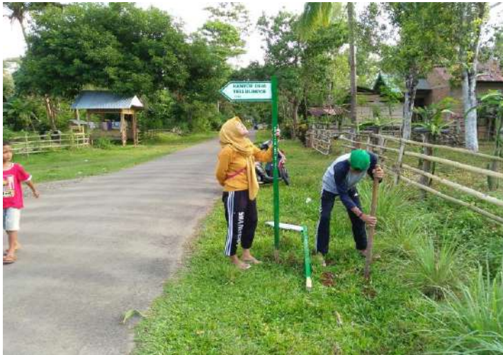
Pemasangan Penunjuk arah Jalan di Dusun Laha-Laha
