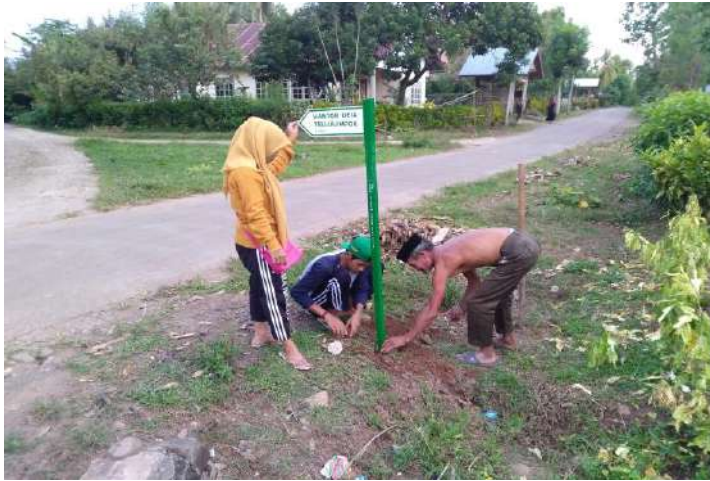
Pemasangan Penunjuk arah Jalan di Dusun Manajo
