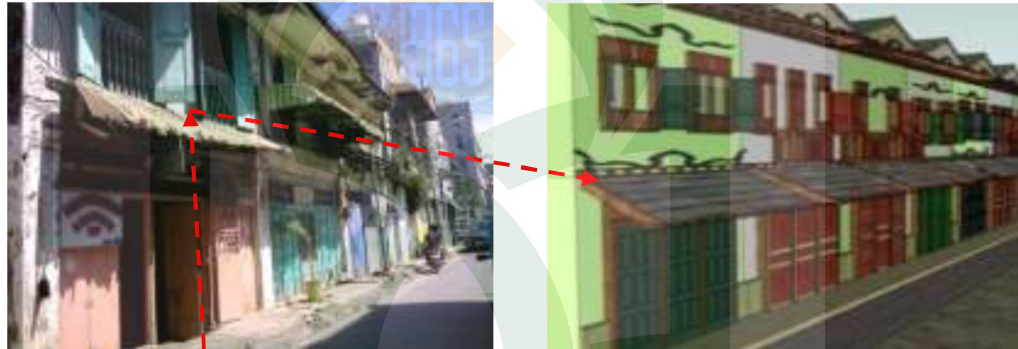
Gambar III.10.Kondisi Fasade Ruas Jalan Sulawesi
