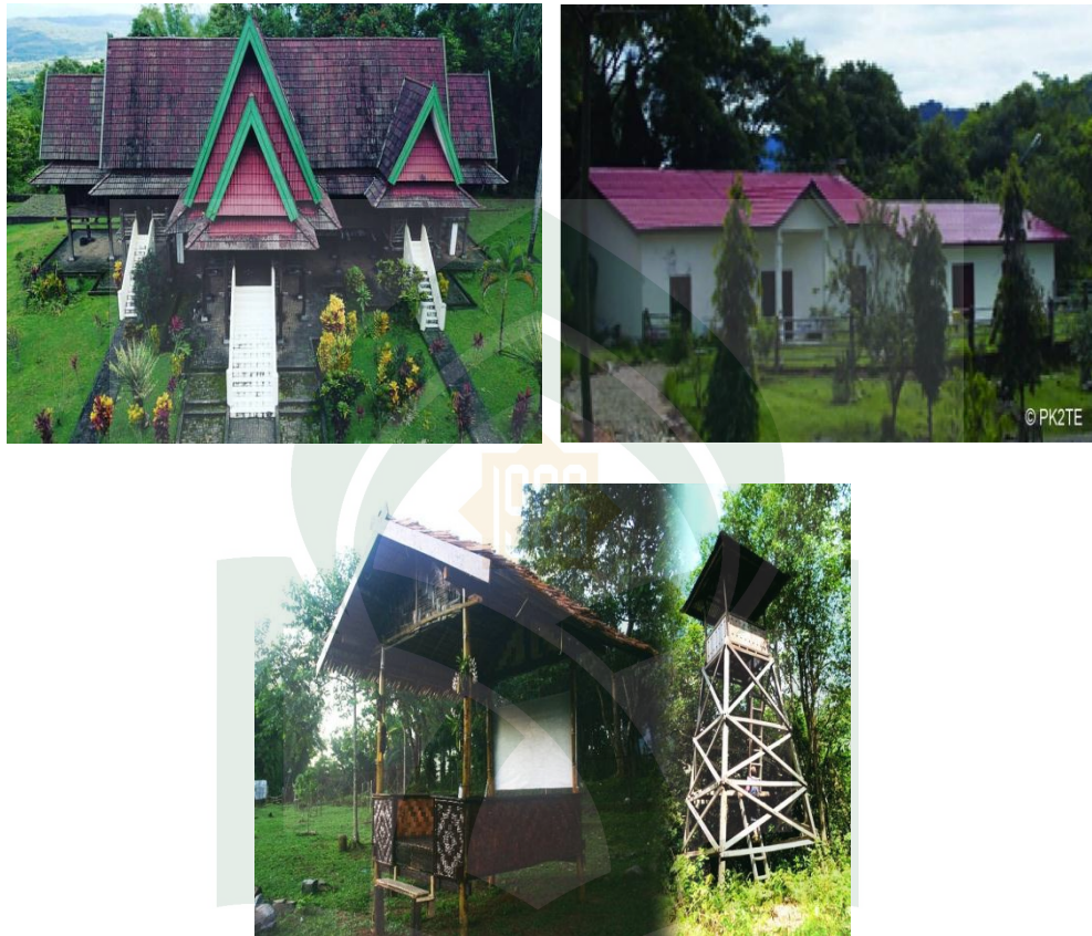
Gambar 4.7. Kondisi Rumah Panggung, Kantor dan Gazebo, 2018.
