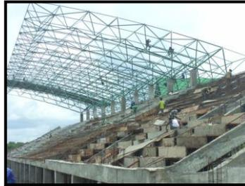
Gambar III.28. Sistem joint pada atap tribun
