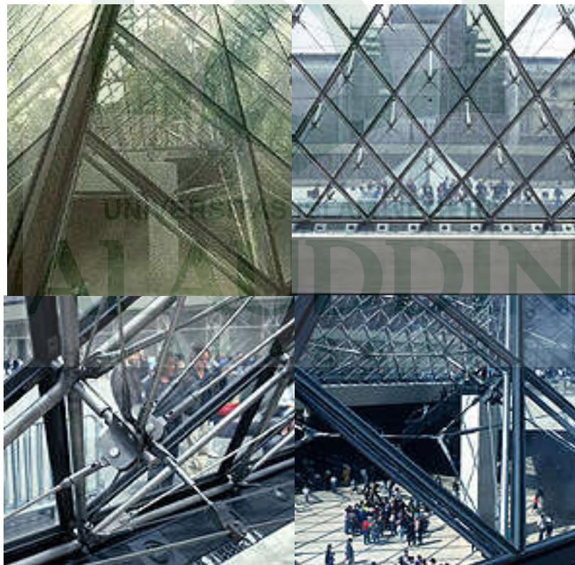
Gambar 22: Material Kaca dan Struktur Baja Museum Louvre Sumber : Wurm, 2007
