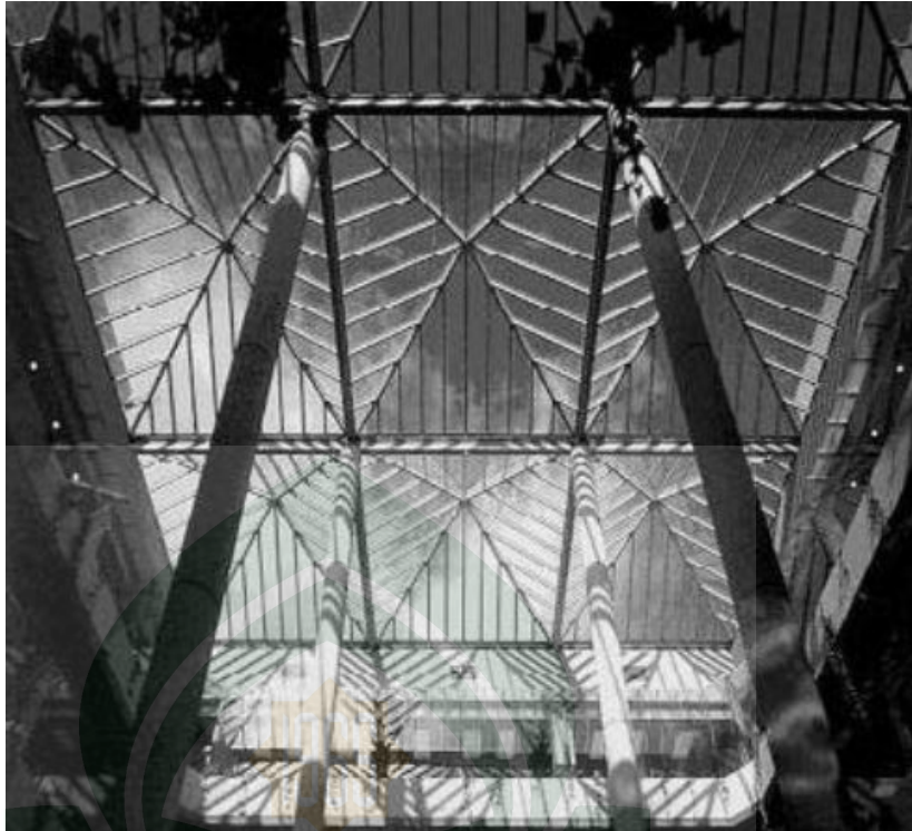
Gambar 11 : Penggunaan laminated glass pada atap bangunan Sumber : Garg, 2007
