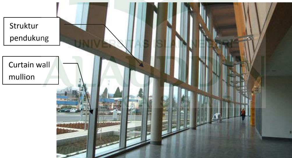
Gambar 67. Konsep Sistem dinding (Analisis Pribadi, 25 September 2016)
