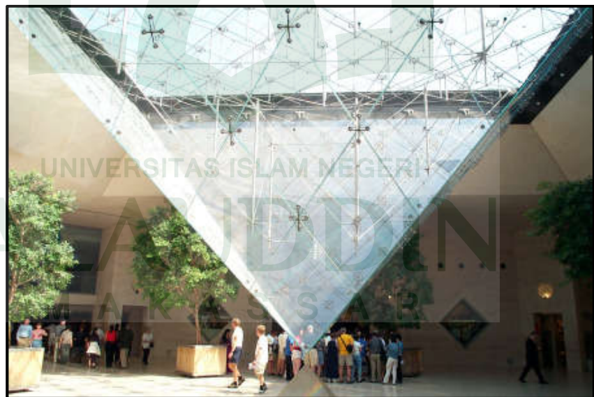
Gambar 21 :Interior Museum Louvre yang menggunakan fitting Spider sebagai pengunci antara kaca.
