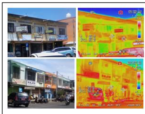
Gambar 5. Kondisi citra suhu permukaan pada fasade bangunan di koridor jalan Mohammad Jam, Kota Banda Aceh
