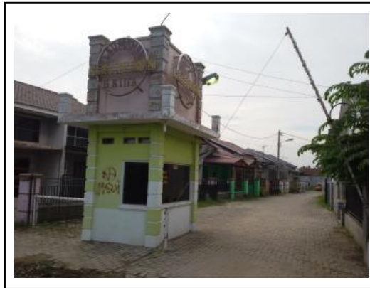
Gambar 4. Eksklusifitas gerbang perumahan Sumber : survey penulis, 2015
