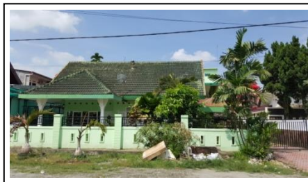
Gambar 7. Fasad Rumah Kos Eunike Sumber: Dokumentasi Pribadi
