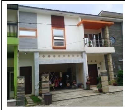
Gambar 2. Fasad Rumah Kos Ibu Devi Sumber: Dokumentasi Pribadi
