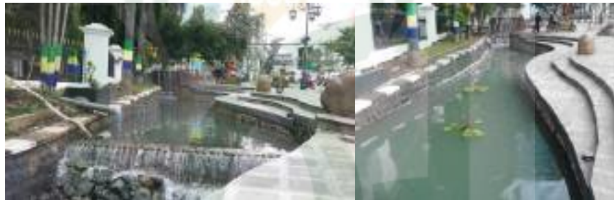
Gambar. II.28 Kolam Ikan dan Penyaringan air
