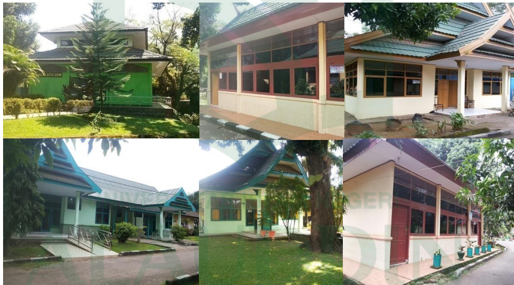
Gambar II. 22. Beberapa Bangunan Penunjang di PSTW Gau Mabaji Gowa (sumber: dokumentasi pribadi,2014)
