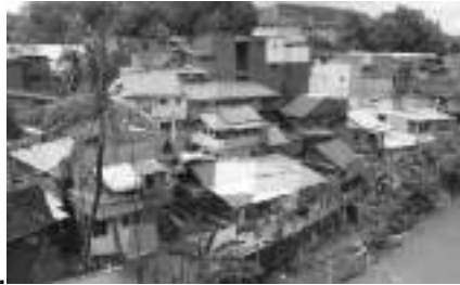
Gambar 34 Permukiman Tepi Kali Code disebut Kampung Kali Code, Yogyakarta (1980).
