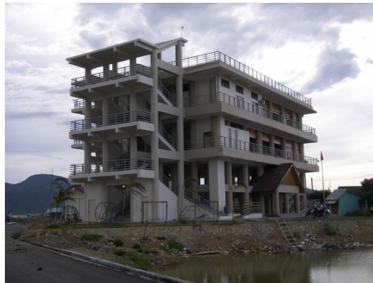
Gambar 5.8. Contoh Bangunan tempat evakuasi Aceh (sumber: JICA 2005)
