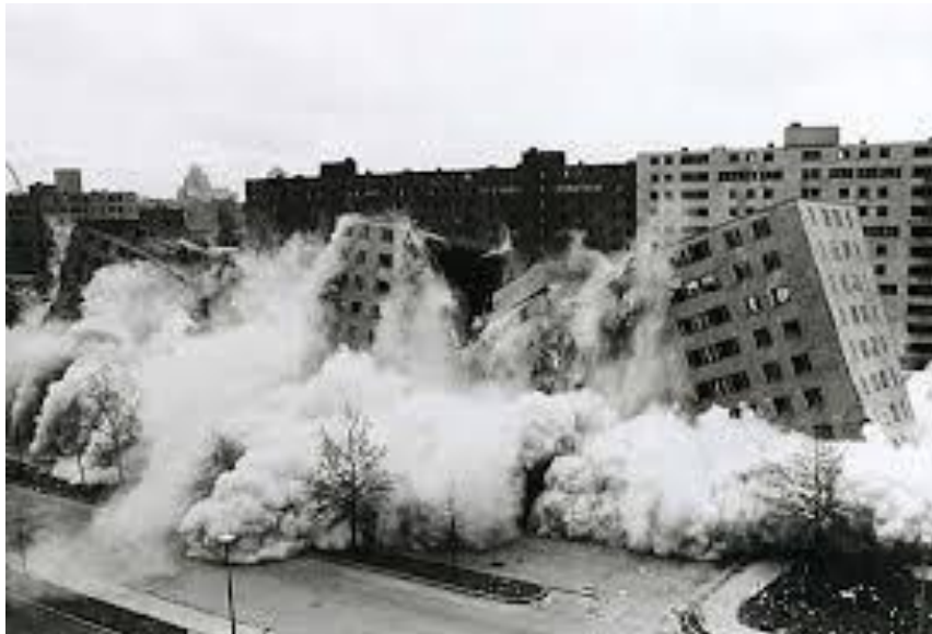
Gambar 2.14 Penghancuran/demolisi Pruitt Igoe di St. Louis, Amerika Serikat Sumber: Morintha (2013)
