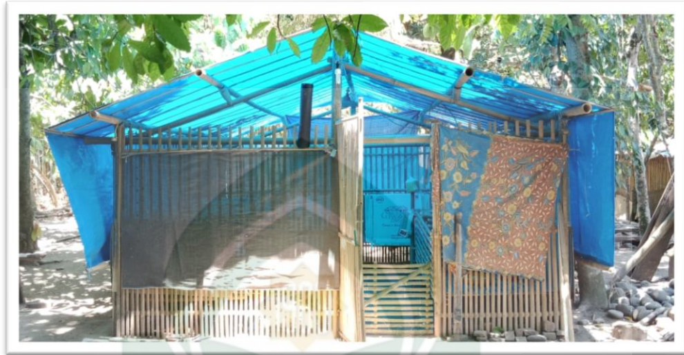
a. Kondisi kandang tampak luar
