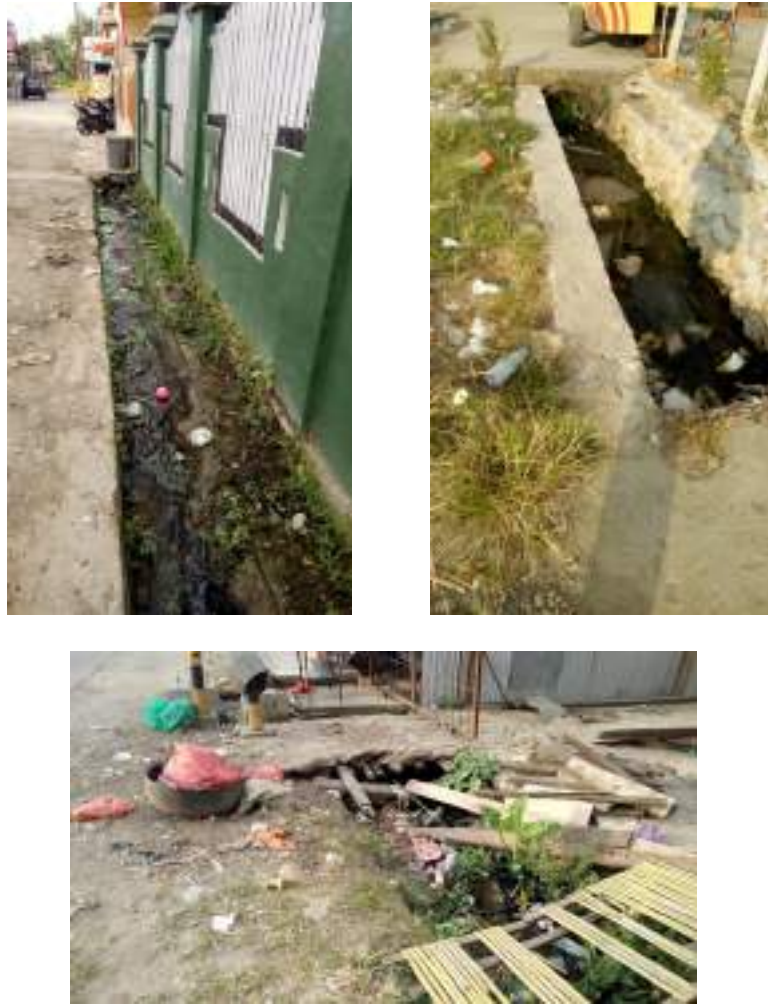
Gambar 31. Kondisi drainase yang tersumbat di Kelurahan Simboro
