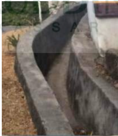
Gambar 14 Prasarana Drainase di Perkampungan Tua Bitombang
