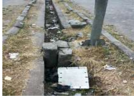
Kondisi Sarana pembuangan Air Hujan dan Air Kotor di areal parkir Terminal
