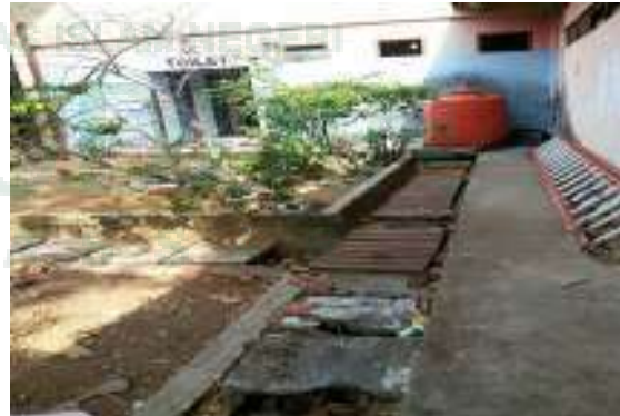
Kondisi Sarana Pembuangan Air Hujan dan Air Kotor di ruang tunggu penumpang
