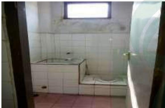
Kondisi Toilet di Gedung Perkantoran Terminal Kendaraan
