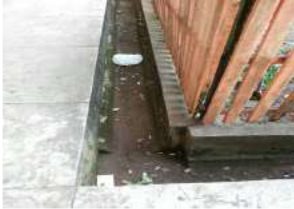
Kondisi Sarana pembuangan Air Hujan dan Air Kotor di gedung perkantoran terminal
