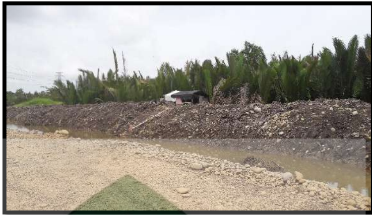
Gambar III.9 Pohon Nipah ditepian Sungai (Sumber: Dokumentasi Lapangan, 2016)
