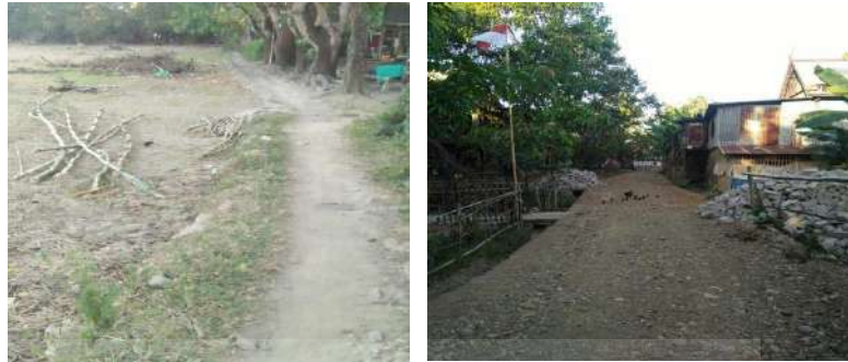
Gambar 4.54 Kondisi jalan kawasan kumuh Bonto Labbere.
