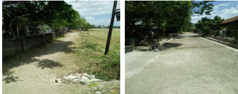
Gambar 4.71 Kondisi jalan kawasan kumuh Bonto Perak. Sumber : Survey Lapangan 2017
