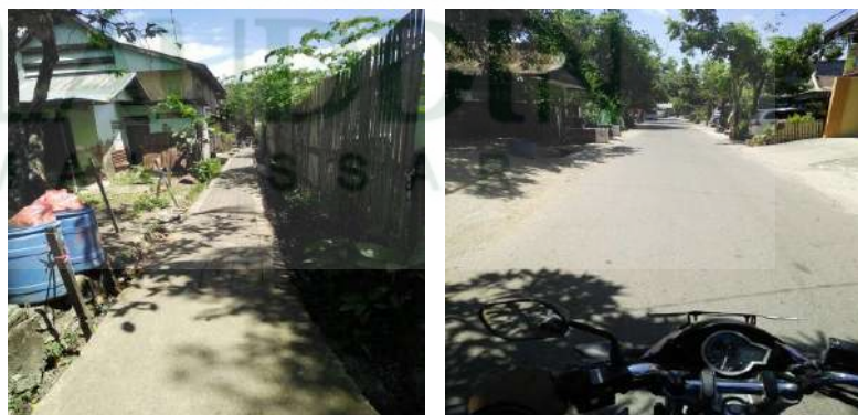
Gambar 4.12 Kondisi Jalan di kampung Tumampua Sumber : Survey Lapangan 2017
