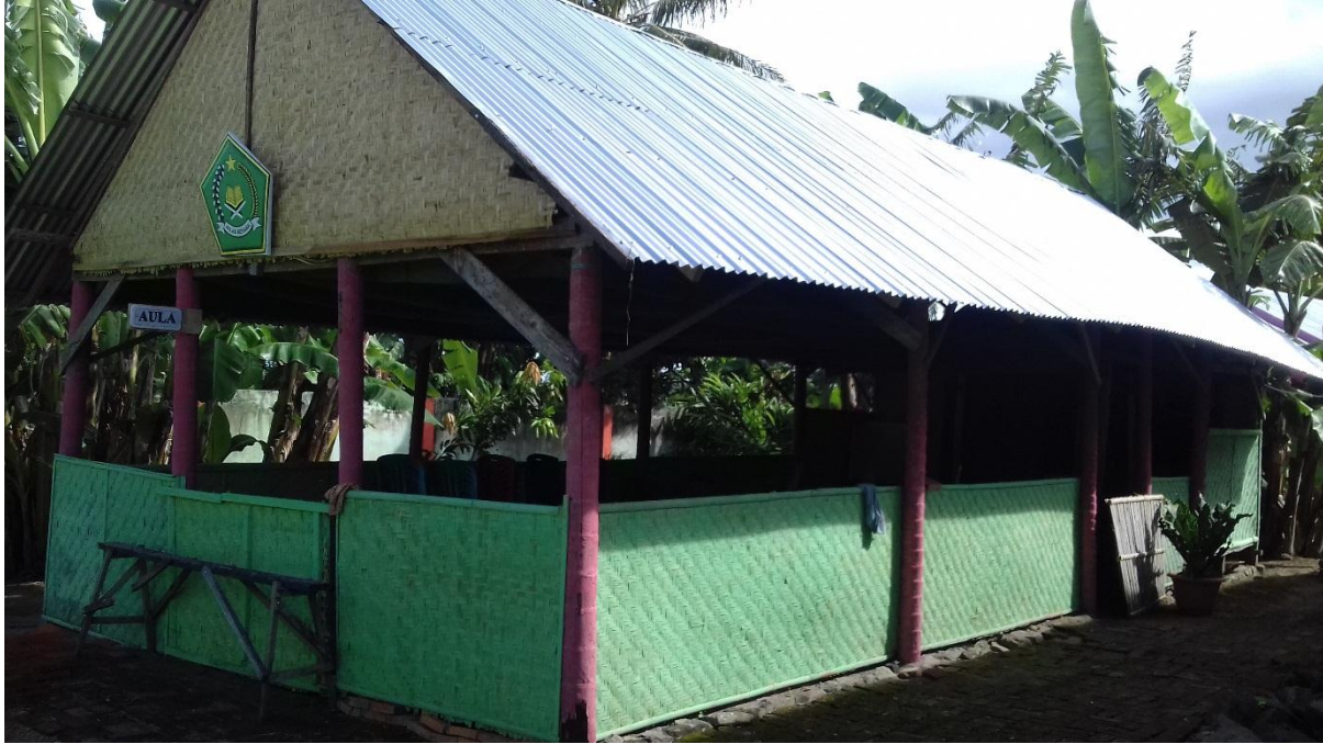
Gambar 10. Aula KUA Kecamatan Patampanua
