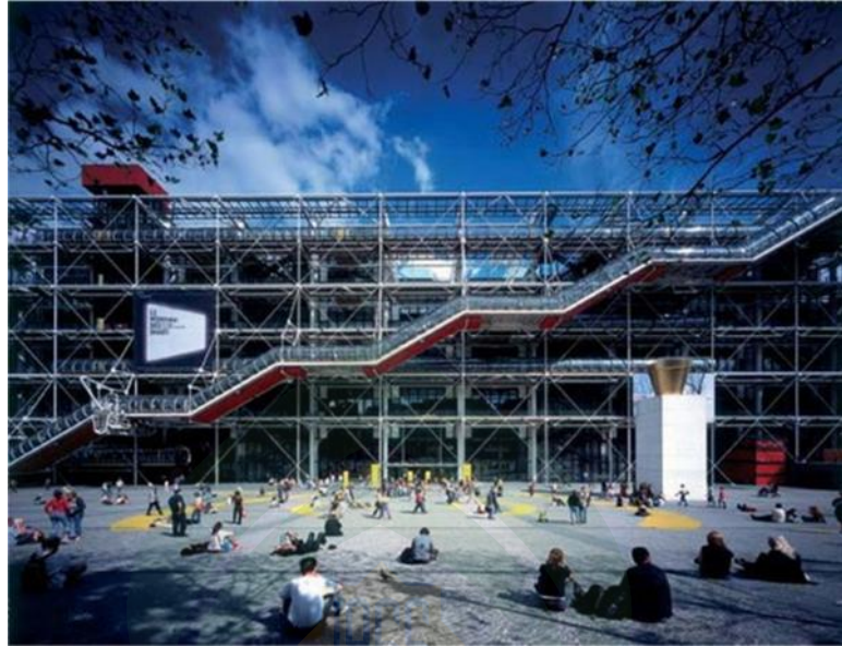
Gambar II.28 The pompidou Centre (Sumber : http://www.archdaily.com/ , diakses pada 01 April 2014)
