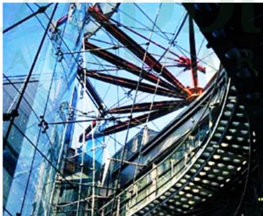
Gambar II.42 Struktur yang menjadi detail eksterior pada bangunan (Sumber : Yulianti, Vicka Widia,2009)
