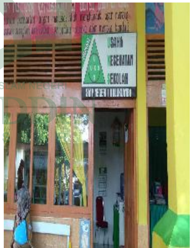
Ruang UKS tampak depan
