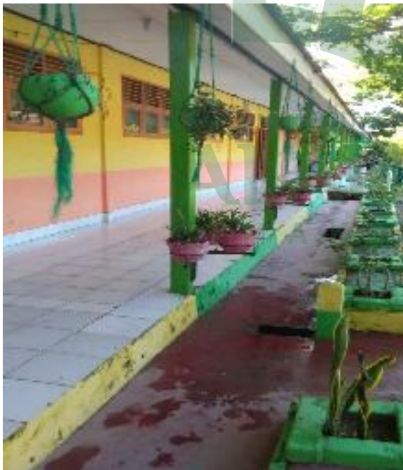
Tampak depan ruang guru, ruang tata usaha dan ruang Kepala Sekolah
