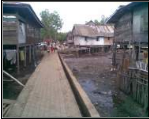
Foto 12 Jaringan Jalan Paving Blok
