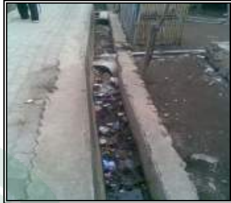
Foto 13 Kondisi Saluran Drainase
