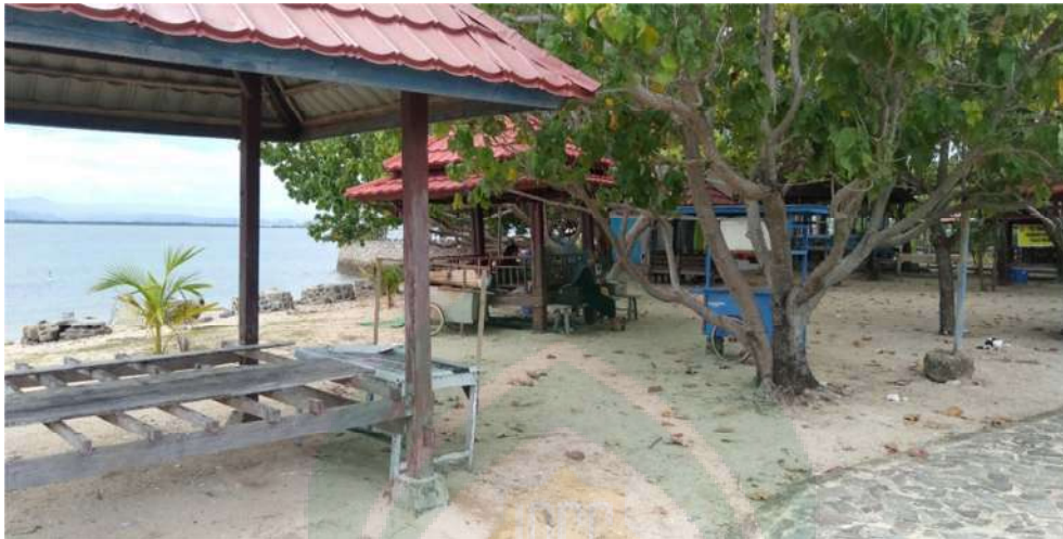
Gambar 12 : Gazebo Pulau Camba-Cambang yang tidak terawat
