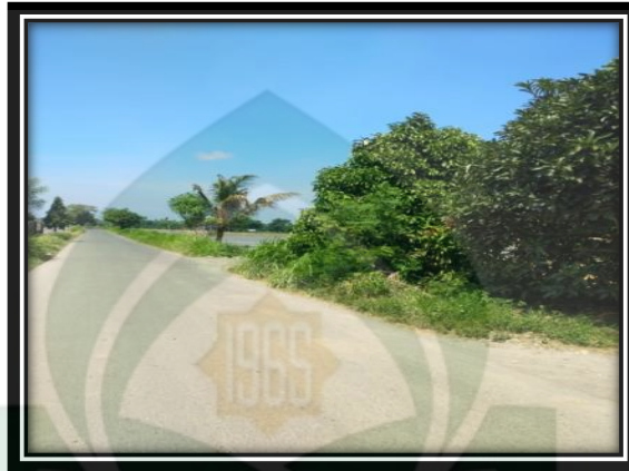
Gambar 4.6 Kondisi Jalan Eksisting
