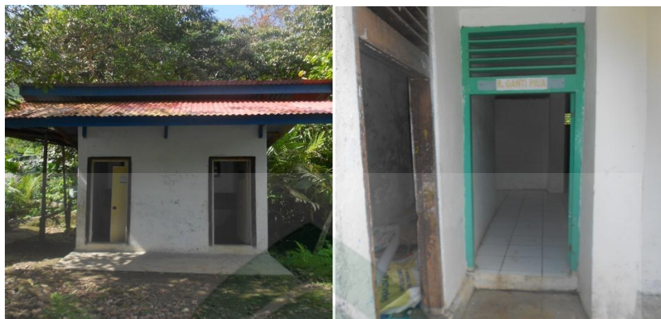
Kondisi Kamar Mandi/Toilet
