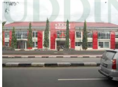
Gambar II.5 Kondisi Tampak Depan BBKPM Makassar (Sumber :Olah Data Lapangan 2017)
