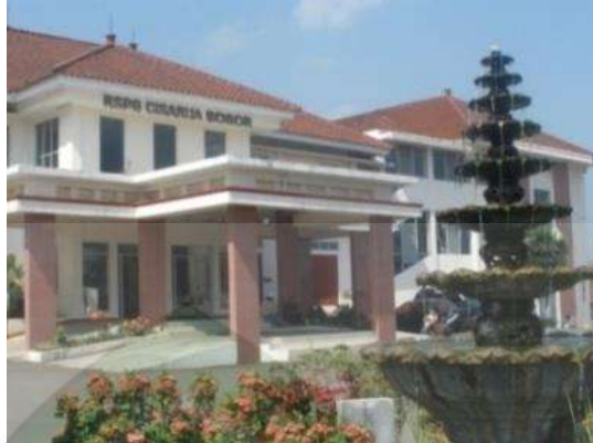
Gambar II.18 Kondisi Tampak Depan RSPG Bogor (Sumber : www.rspg-cisarua.co.id , diakses tanggal 12 Desember 2017)
