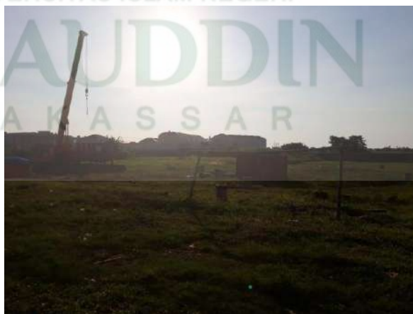
Gambar III.3 Tapak Jalan Metro Tanjung Bunga (Sumber : Olah Data,20 Oktober 2018)
