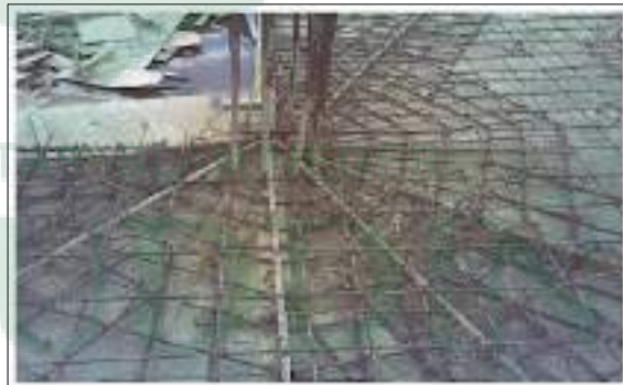
Gambar III. 36 Pondasi Rakit Sumber : https://www.dataarsitek.com , diakses Januari 2019
