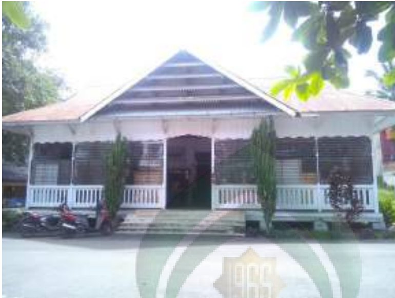
Gambar 2 . Dekumentasi Gedung dan Fasilitas Perpustakaan Gedung
