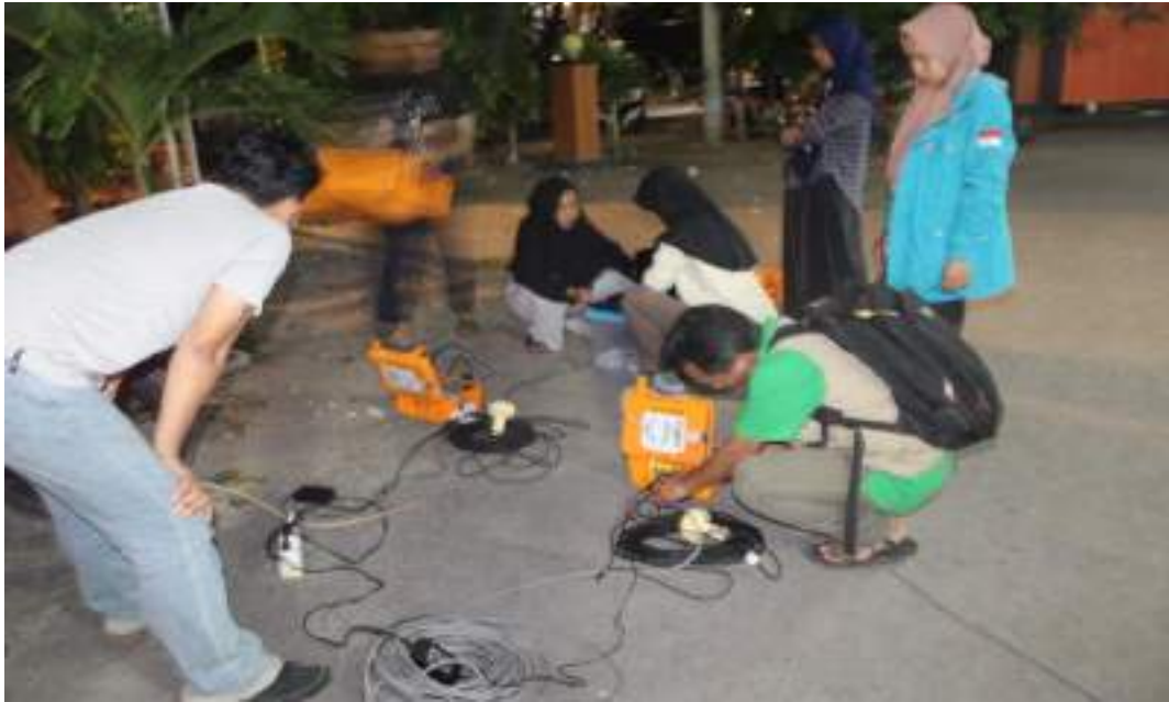
Foto persiapan pemasangan alat Mikrotemor di tanah timbunan
