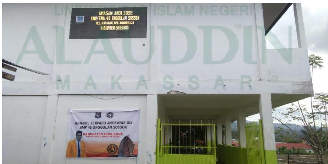
Gambar 1. Tampak Depan SMA 45 Unggulan Sossok Kabupaten Enrekang
