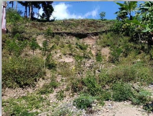
Gambar 4.16 Kerusakan Jalan di Kelurahan Bonto Lerung
