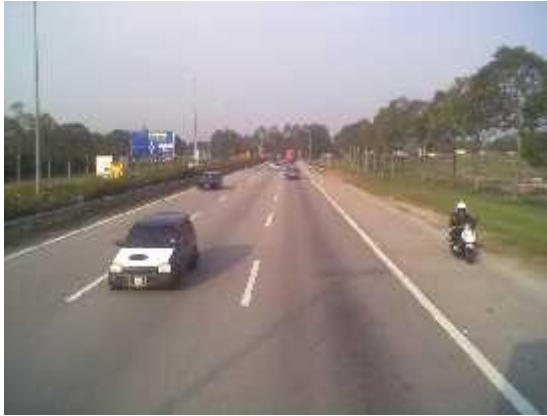
Gambar III.32 Jalan (Sumber : Olah data, 2015)
