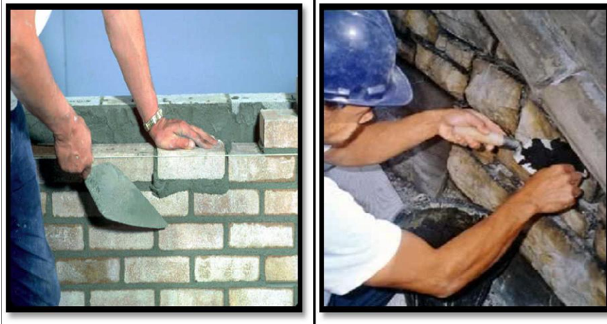
Gambar 2.9: Pelaksanaan Pemasangan bata menggunakan mortar
