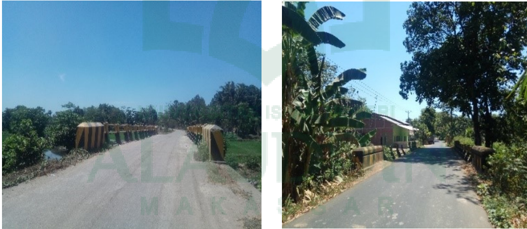
Gambar 12. Jembatan Kecamatan Bontonompo
