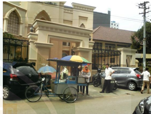
Tempat Parkir yang dimiliki Masjid Jenderal Sudirman Makassar
