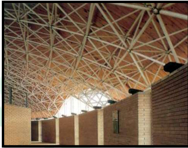
Gambar III.36 Struktur space truss Sumber : Google , (diakses 5 Agustus 2019)
