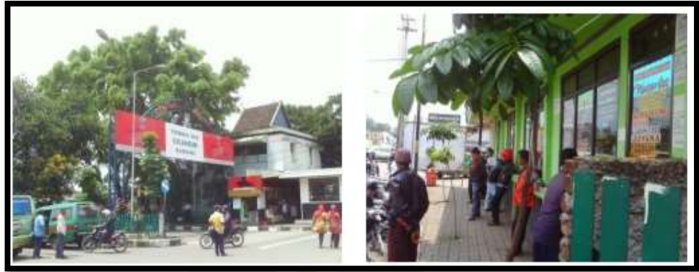
Gambar II.20 Keadaan Terminal Cicaheum Sumber: Tofani, Logi. Studio Perancangan Tugas Akhir (diakses tanggal 10/06/2019)
