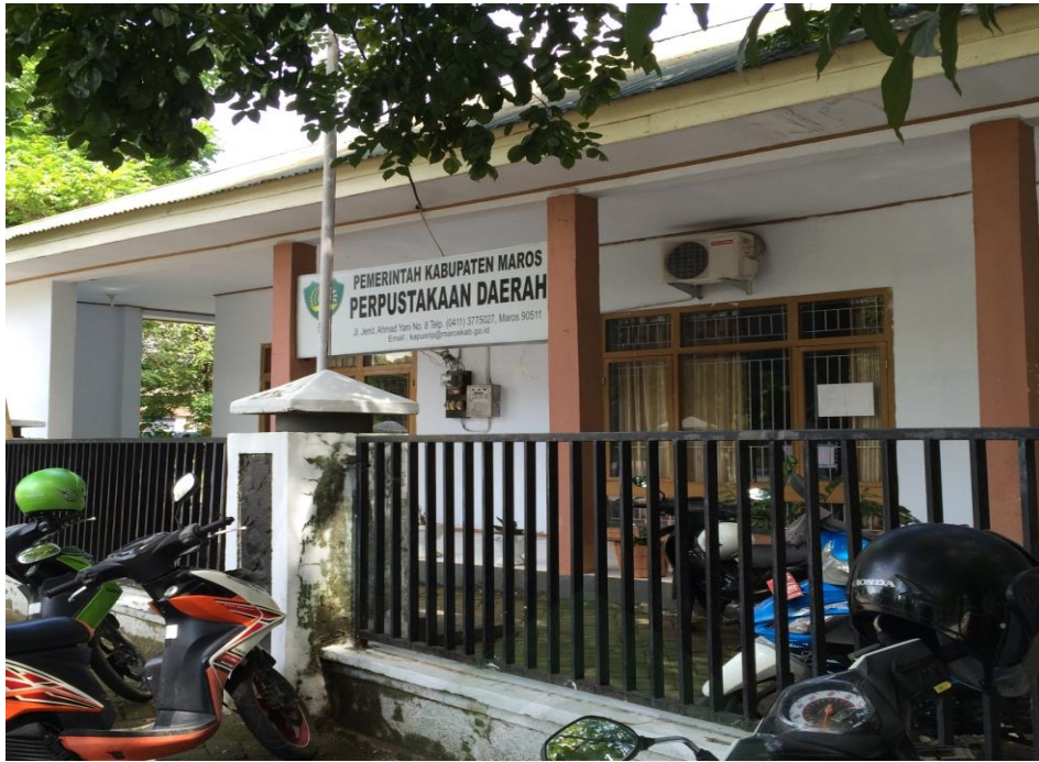
Tampak Depan Perpustakaan dan Arsip Kabupaten Maros
