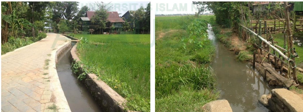
Gambar 19 Kondisi Drainase Lingkungan di Kmapung Romang Tangaya
