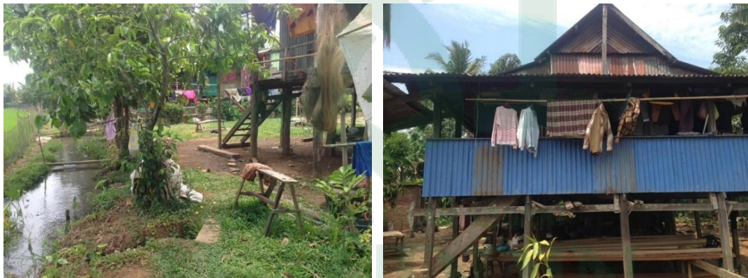
Gambar 13. Bangunan di Kampung Romang Tangaya
