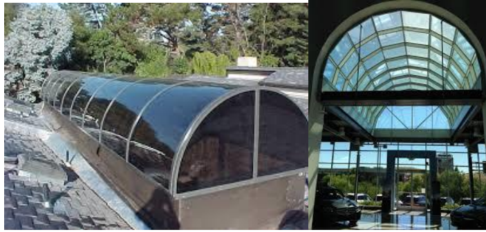
Gambar II 27 Contoh bentuk dan penggunaan barrel vault skylight (Sumber: www.google.com/images , diakses 16 September 2019)
