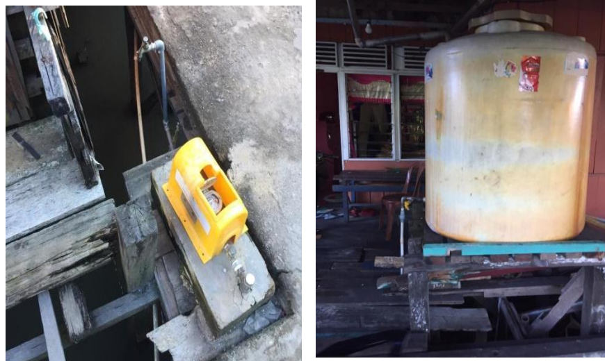
Gambar 24. Kondisi jaringan air bersih Permukiman Terapung
