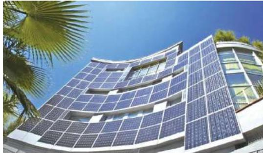
Gambar II.16 Pemasangan Fixed Array PV pada Dinding Bangunan
