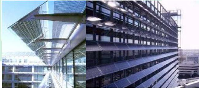
Gambar II.15 Pemasangan *Fixed Array PV* pada *Lisplank Overstack*
