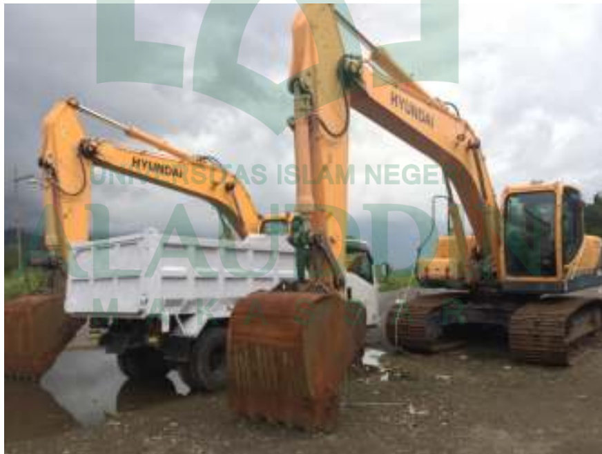
Foto proses penggalian eskapator pasir di pertambangan
