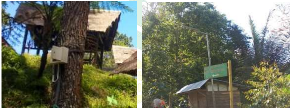
Gambar 9 Prasarana Listrik (kiri, gardu listrik; kanan, lampu jalan menuju tempat wisata, lampu jalan tempat wisata)
