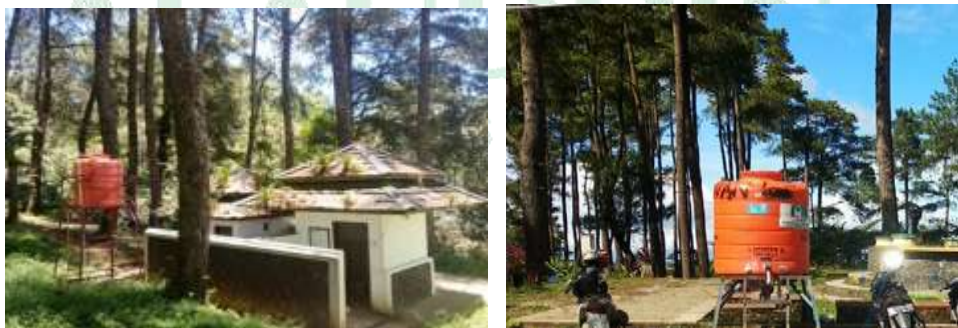
Gambar 10 Prasarana air bersih(kiri, tempat penampungan air ; kanan, tempat cuci tangan)
