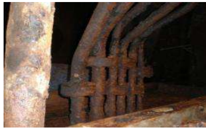
Gambar 2.2: Korosi seragam pada pipa ballast Sumber: (Utomo, 2009)
