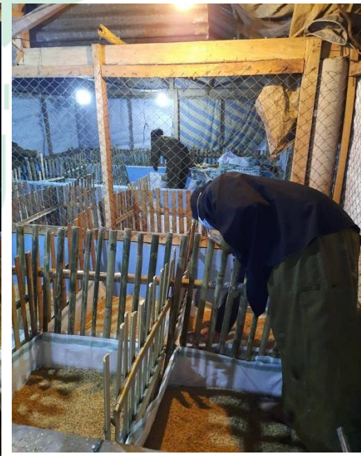
4. Pemasangan Dinding Kandang
