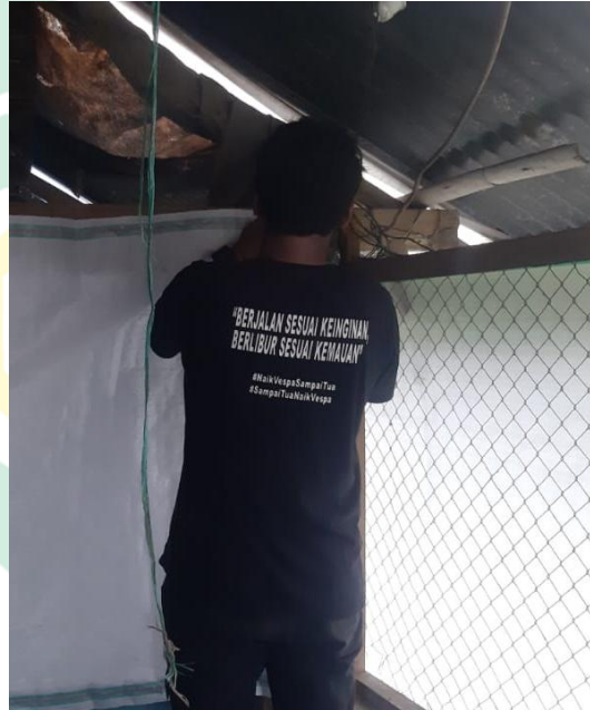
2. Pemasangan Dinding Kandang
